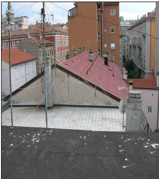
Foto 4 – Particolare fotografico dal quale si evince le tipologie di copertura dell'edificio: a sinistra copertura a falde, a destra copertura a terrazza
