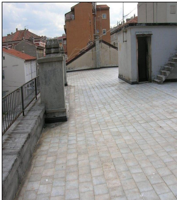
Foto 4 – Particolare fotografico dal quale si evince le tipologie di copertura dell'edificio: a sinistra copertura a falde, a destra copertura a terrazza
