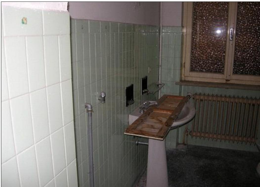
*Foto 2 - stato manutentivo pavimentazione e rivestimenti bagno (piastrelle di ceramica e marmetta)*
