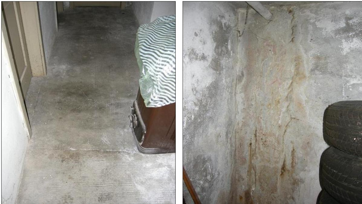
*Foto 8 – Particolare fotografico della pavimentazione cantine pertinenziali e perdite scarichi vani cantine*
