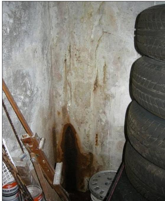
*Foto 3.- infiltrazioni di acque piovane e acque di scarico*
