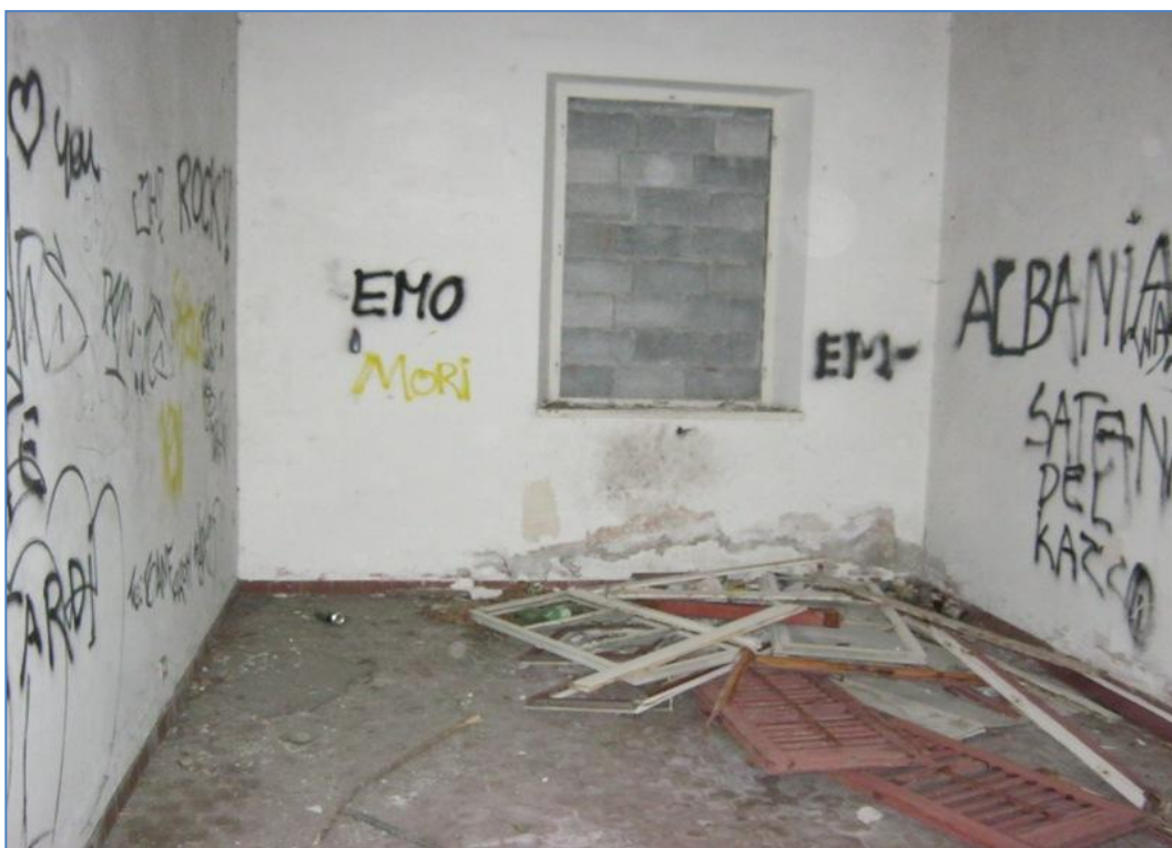
Foto 2 - stato manutentivo pavimentazione delle camere.
