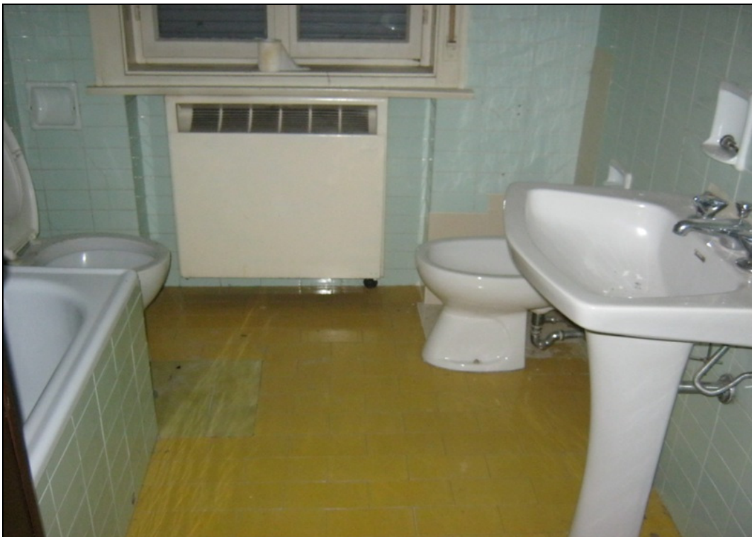
Foto 2 - stato manutentivo pavimentazione e rivestimento del bagno.
