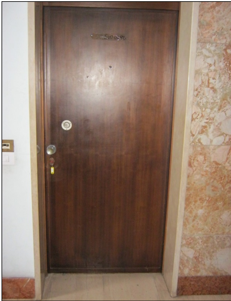
Foto 5 – porta esterna d'ingresso.
