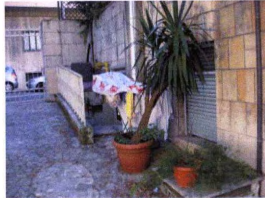
dettaglio affaccio e vista del secondo ingresso carrabile su via Monti Parioli
