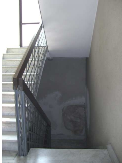
Scala d'ingresso alle cantine
