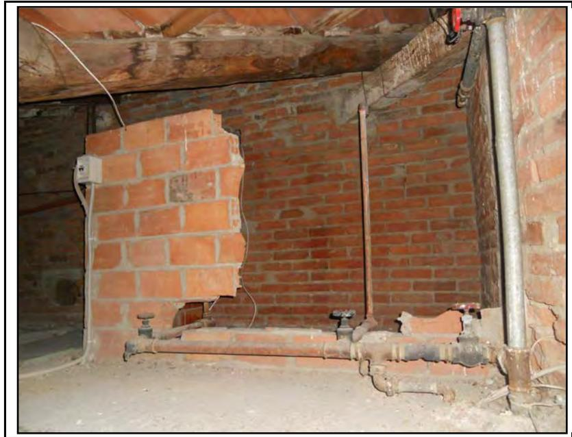
**Foto 28 – Sottotetto. Tubazioni impianto di riscaldamento centralizzato**
