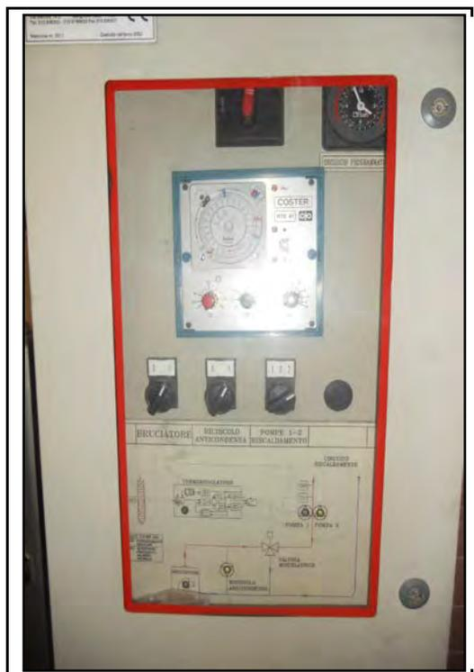
**Foto 39 – Centrale Termica. Dispositivi di controllo**
