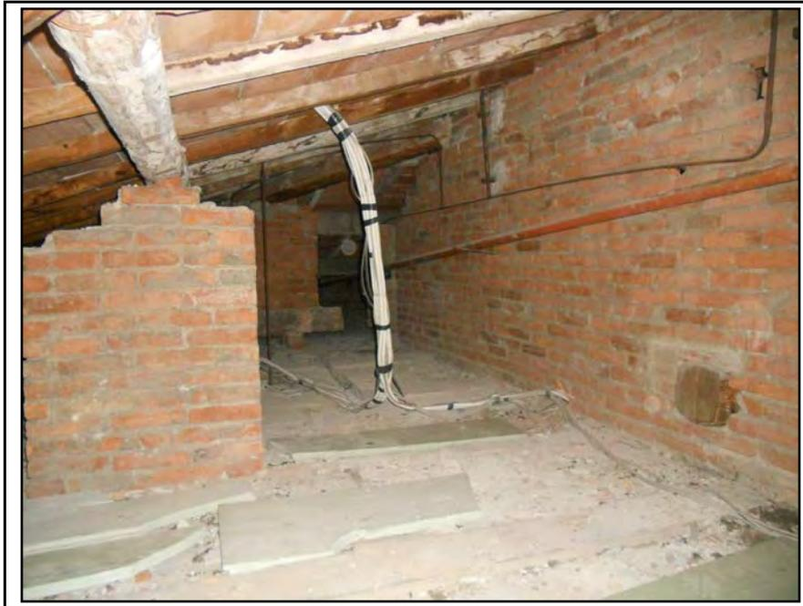
**Foto 29 - Sottotetto. Struttura lignea con tavelloni e cavi antenne**
