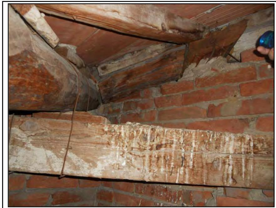
**Foto 30 – Sottotetto. Particolare di appoggio trave**
