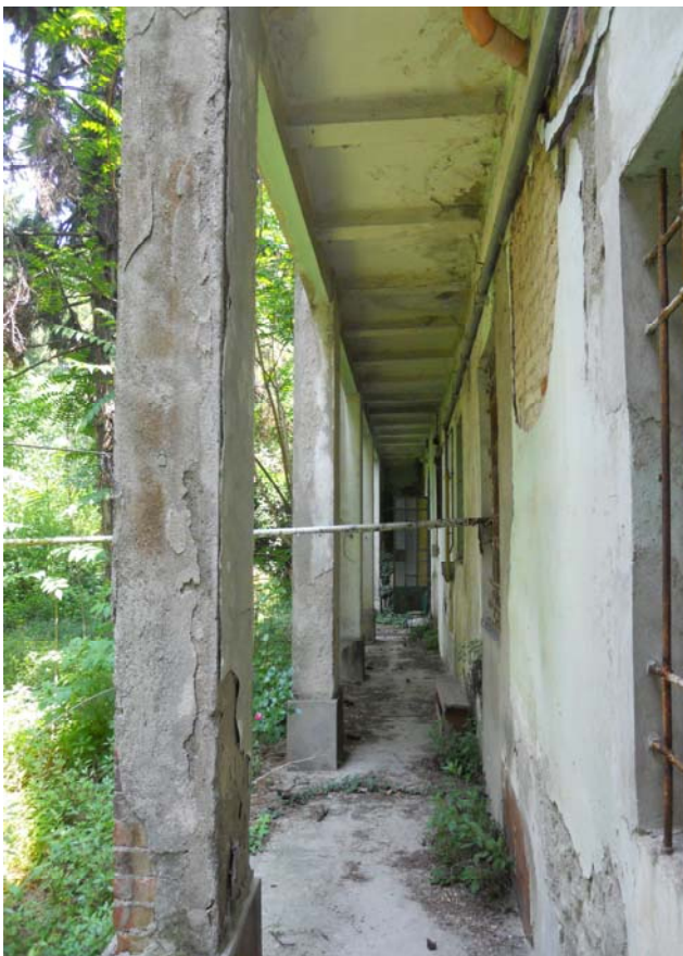
porzione prospetto interno sottostante veranda
