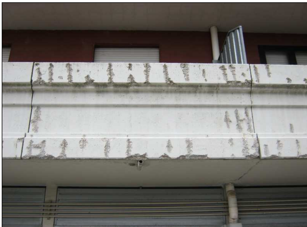
Foto 5 - Particolare fotografico dal quale si evince lo stato conservativo del copri ferro presente nei balconi.
