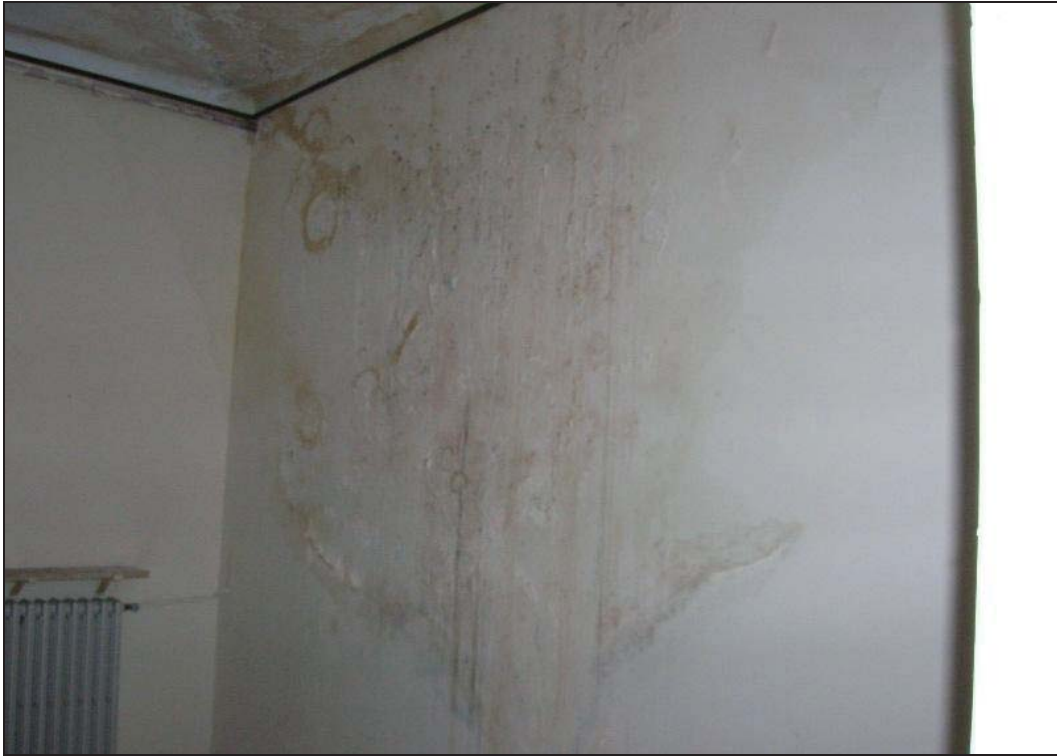
Foto 7 - stato manutentivo pareti e soffitti.
