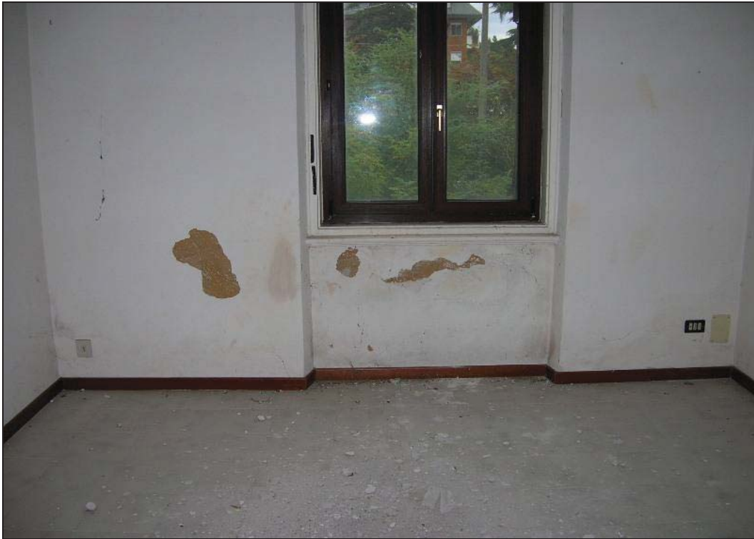
Foto 1 - stato manutentivo pavimentazione delle camere.
