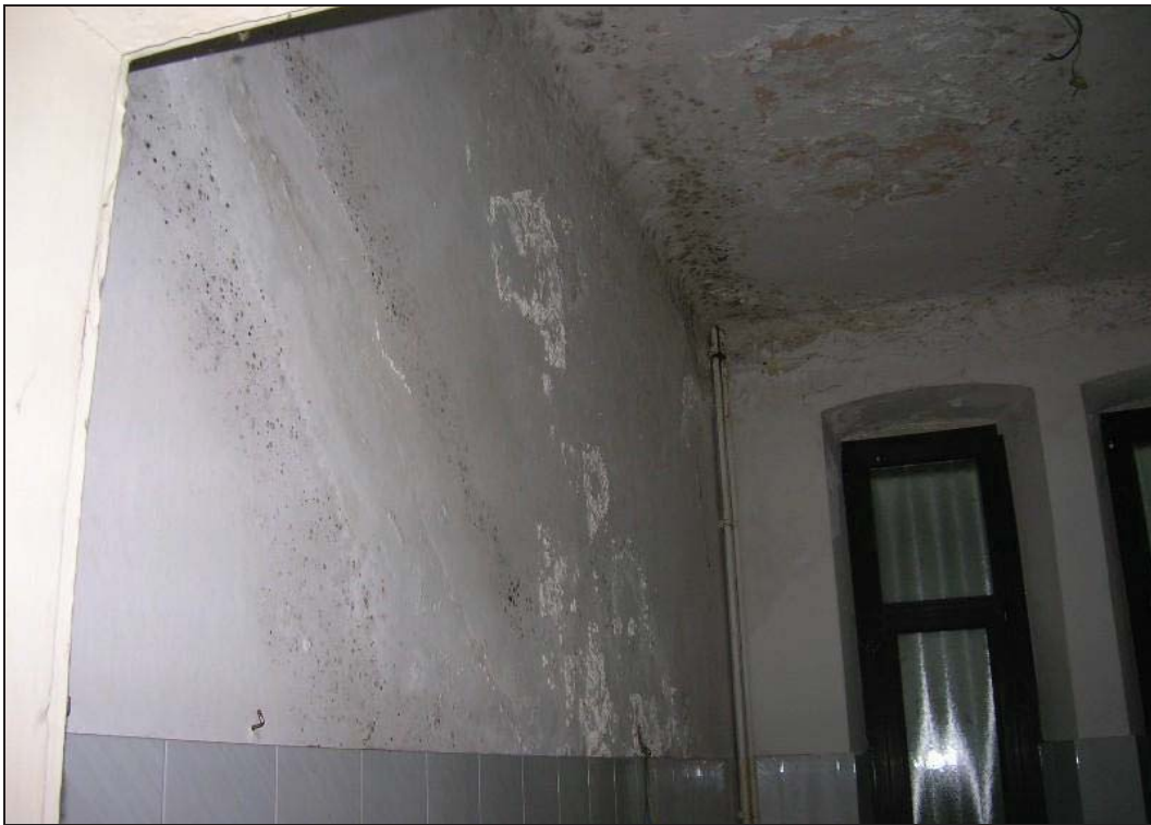
Foto 6 – stato manutentivo pareti e soffitti.
