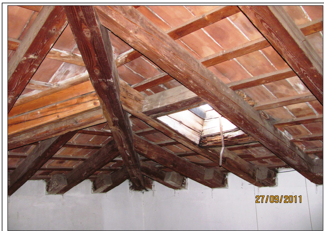
Foto 5 - Particolare fotografico dal quale si evince parte dell'orditura del tetto.
