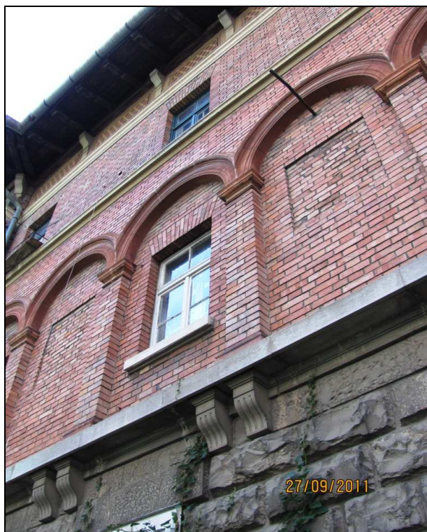
Foto 6 - Particolare fotografico dal quale si evince la tipologia di struttura mista.
