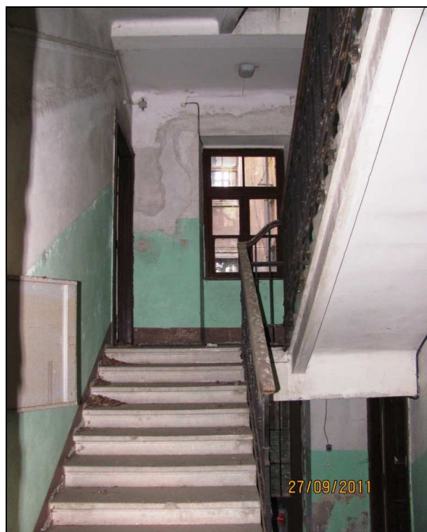
Foto 9 - Corpo scala dal quale si evince le buone condizioni della pavimentazione.
