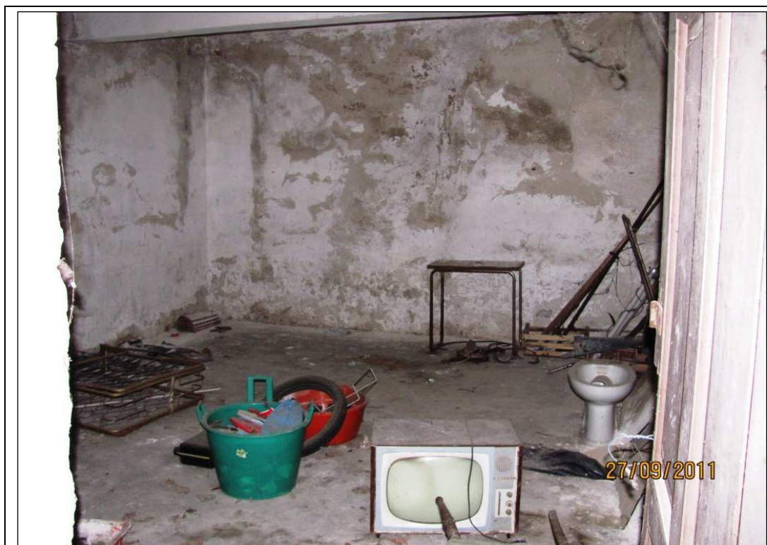
Foto 11 – Particolare fotografico dove si evidenziano le condizioni interne cantina pertinenziale.
