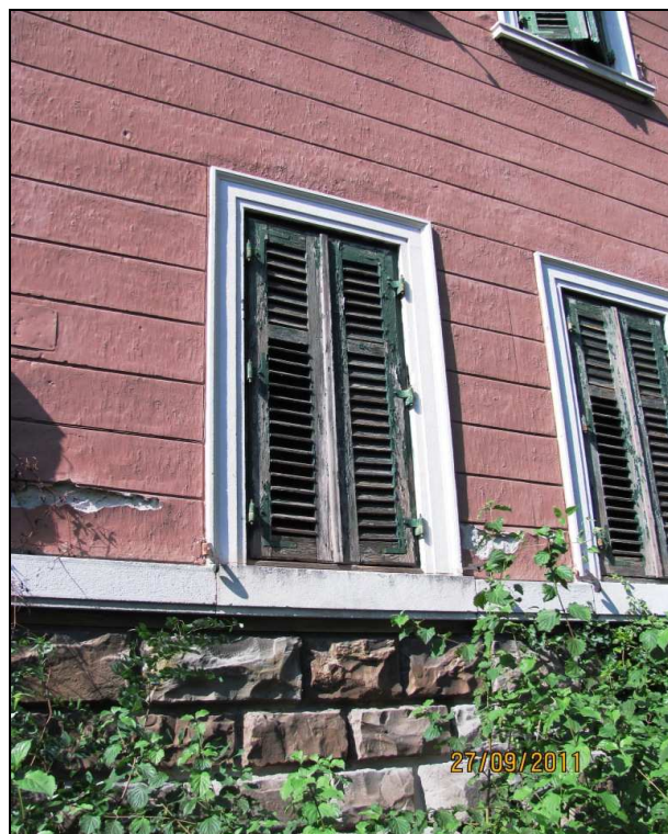
Foto 7 - Particolare fotografico dal quale si evince la tipologia di ante d'oscuro.
