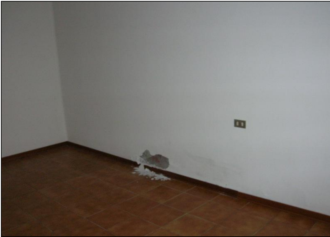
Foto 3 - stato manutentivo pavimentazione del soggiorno dell'appartamento.
