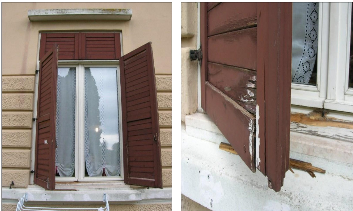
Foto 7 - Particolare fotografico dal quale si evince la tipologia e lo stato di conservativo degli infissi esterni e delle ante d'oscuro.
