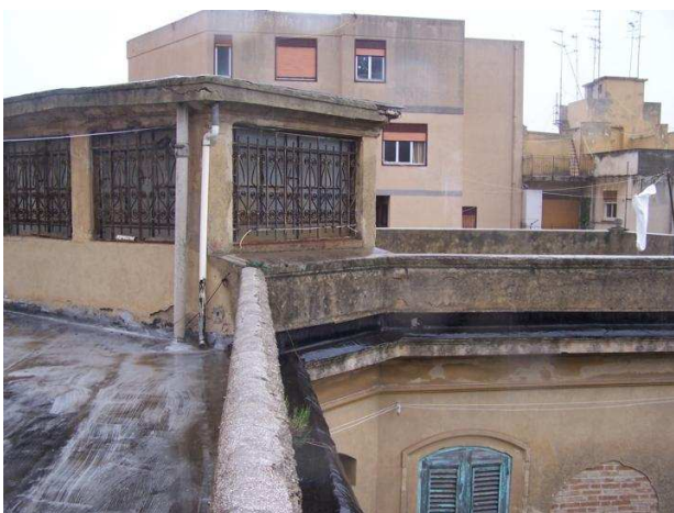
29 Torrino e copertura
