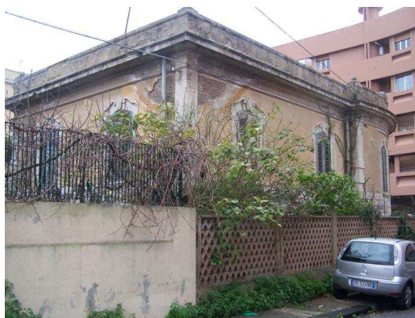
2 Prospetto lato strada
