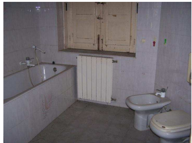
18 Piano rialzato locale servizi igienici
