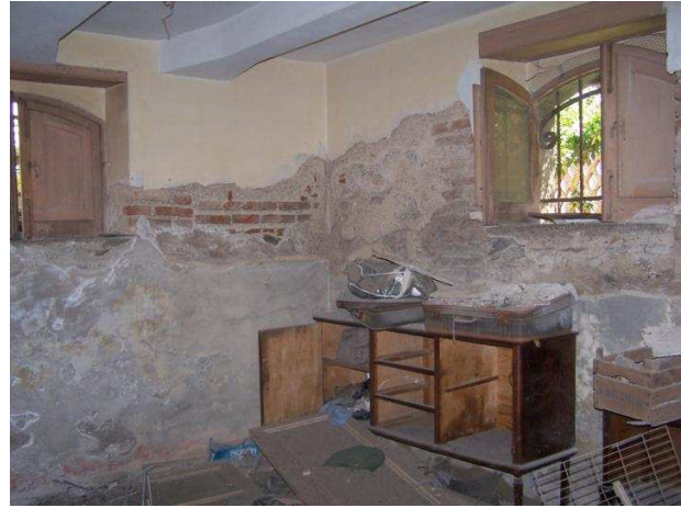
26 Locale seminterrato- Particolare muro esterno
