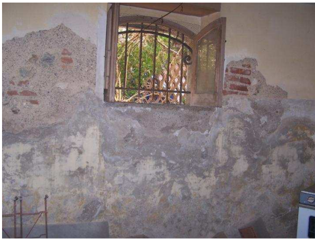
25 Locale seminterrato – Particolare finestra e parete
