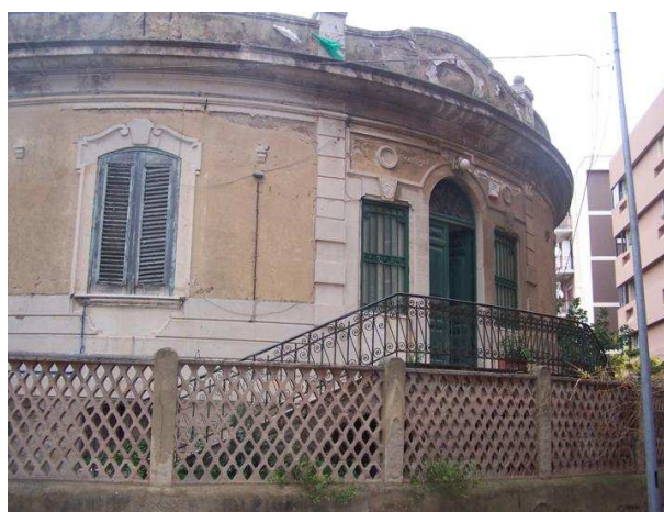
4 Particolare prospetto sud-est
