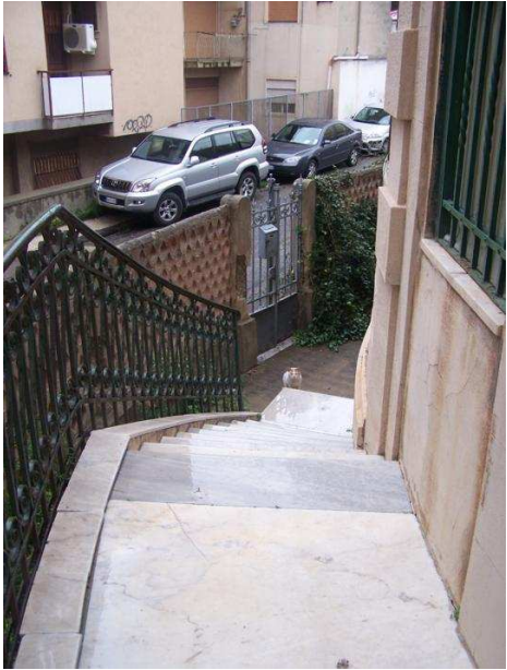
7 Particolare scala accesso ingresso principale
