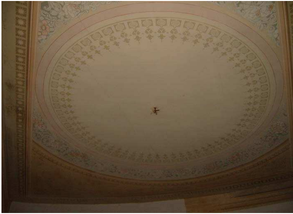
19 Piano rialzato - particolare soffitto
