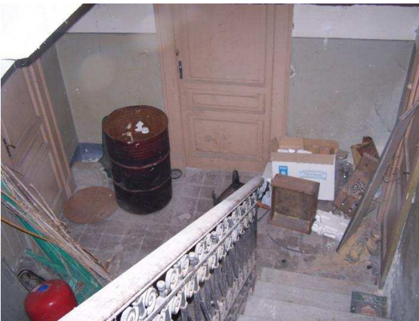
23 Piano seminterrato - Vano disimpegno
