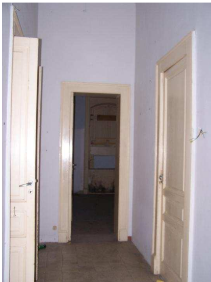
17 Piano rialzato locale corridoio
