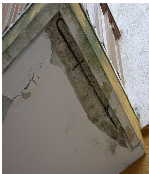
Foto 9 - Particolare fotografico del distacco della tinteggiatura nella facciata esterna
