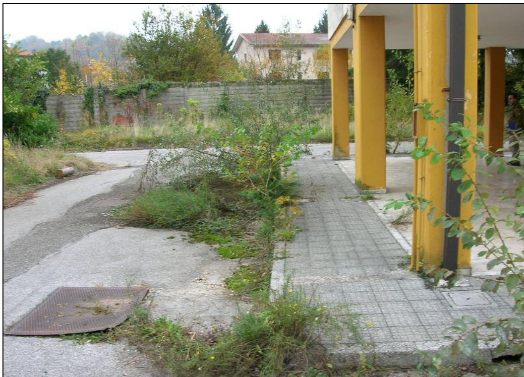
Foto 5 - Particolare fotografico del muro di recinzione in pannelli prefabbricati.
