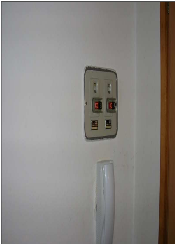
Foto 8: quadro elettrico d'appartamento e generale
