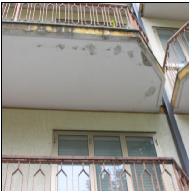
Foto 8 - Particolare fotografico delle condizioni dell'intonaco della facciata esterna
