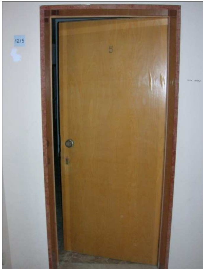
Foto 6: porta in legno d'ingresso rinforzata.
