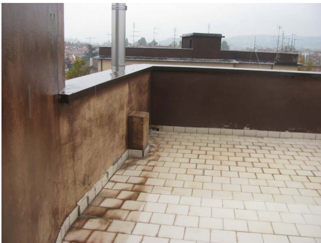
08. Lastrico solare (bene comune) P.5° - particolare
