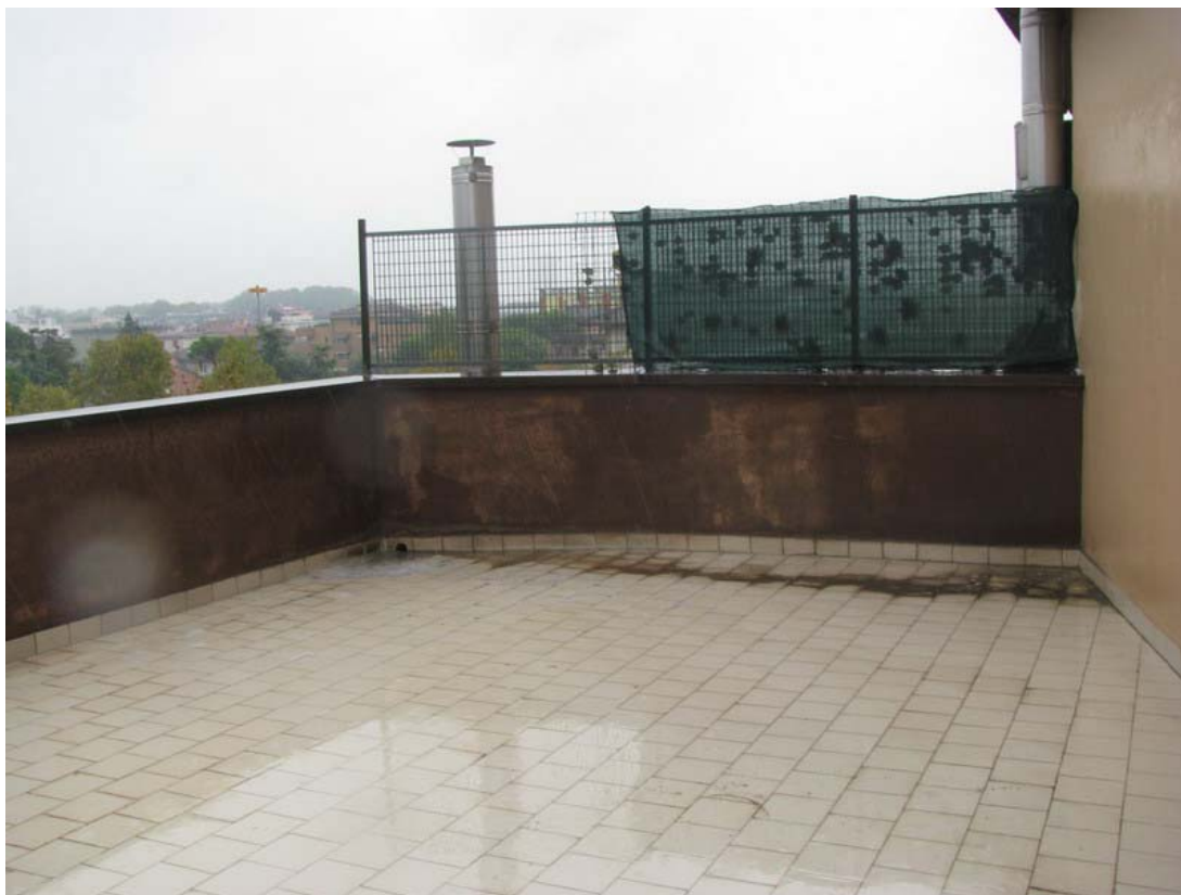
07. Lastrico solare (bene comune) P.4° - particolare
