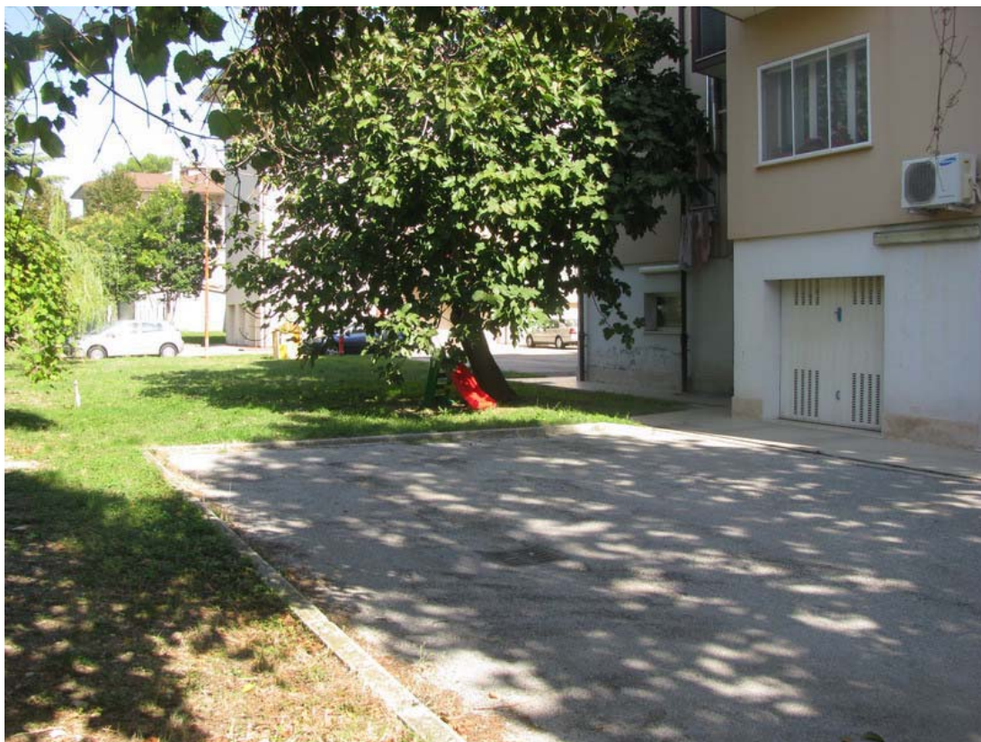
03. Fronte lato ovest
