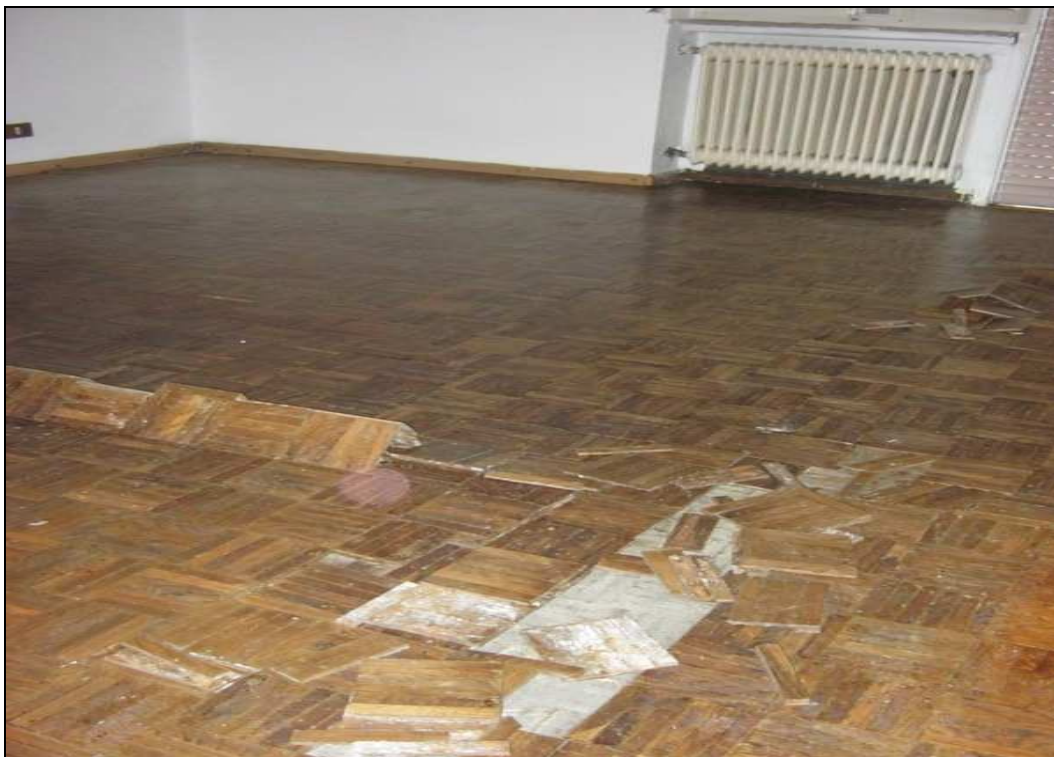
Foto 3 - stato manutentivo pavimentazione delle camere.
