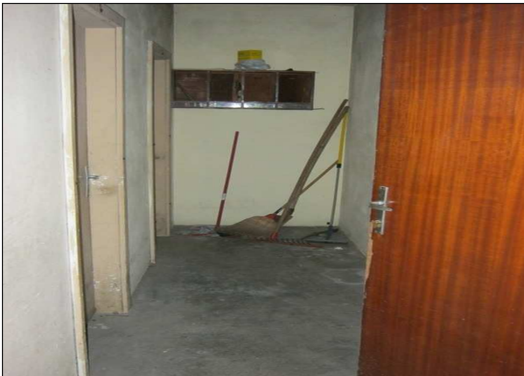
Foto 4 – Particolare fotografico dal quale si evincono le caratteristiche principali del piano scantinato.
