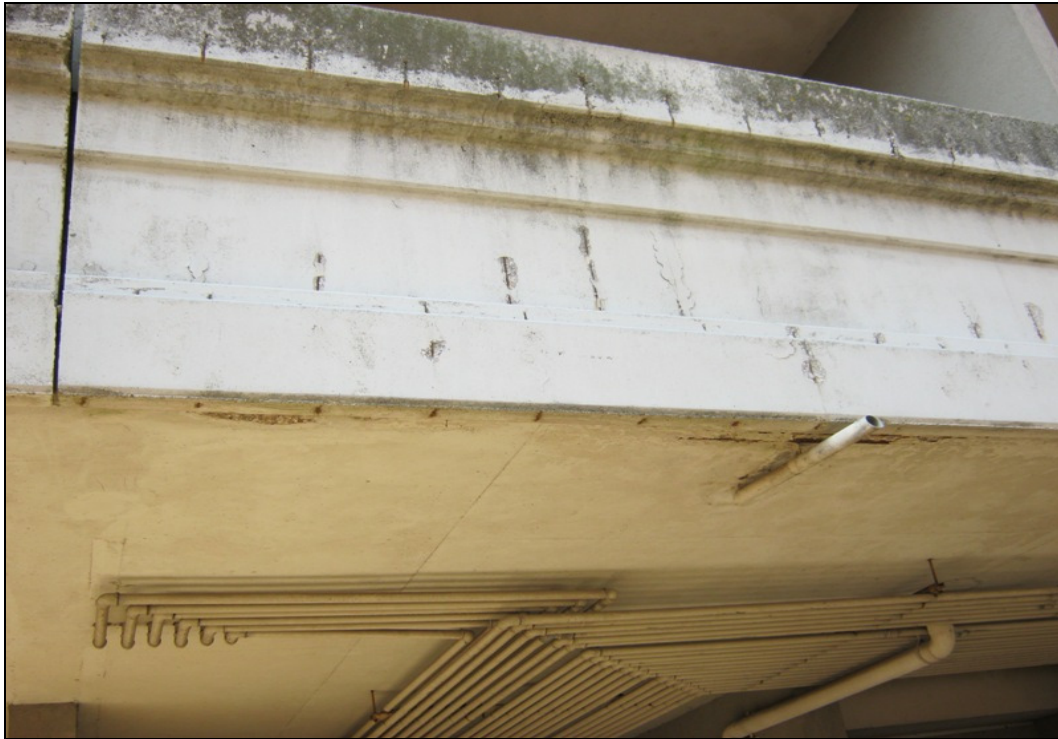
Foto 4 - Particolare fotografico dal quale si evince lo stato conservativo delle facciate esterne, in particolare del cedimento di copri ferro dei balconi.
