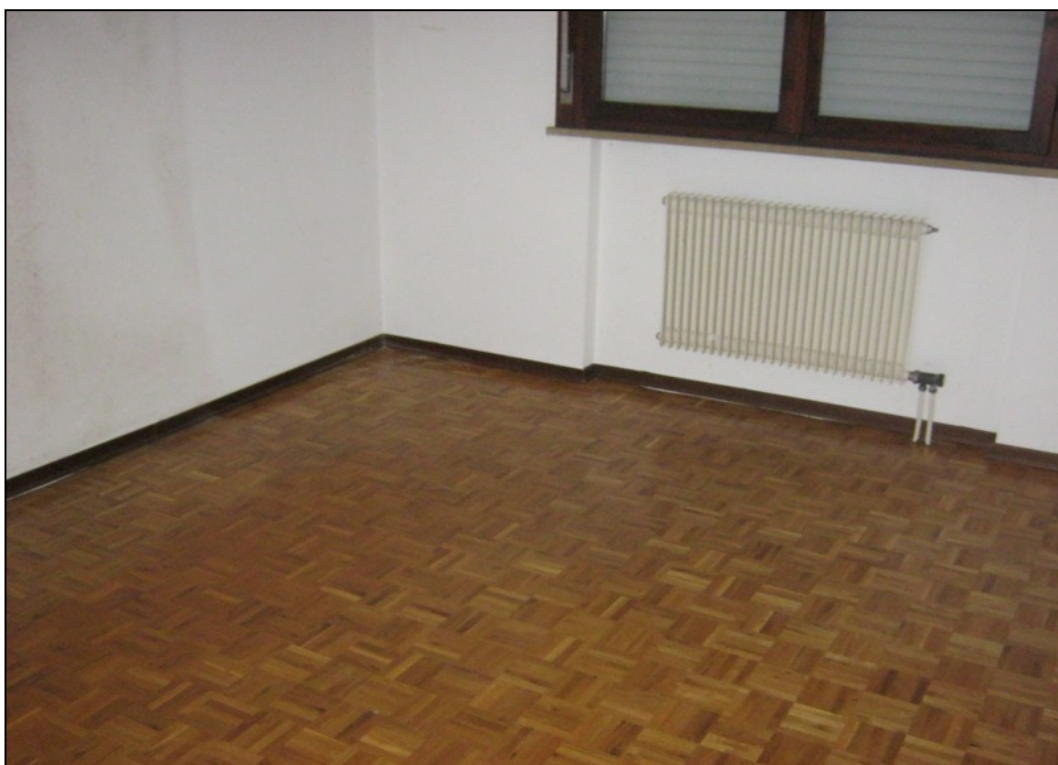
Foto 2 - stato manutentivo pavimentazione delle camere.
