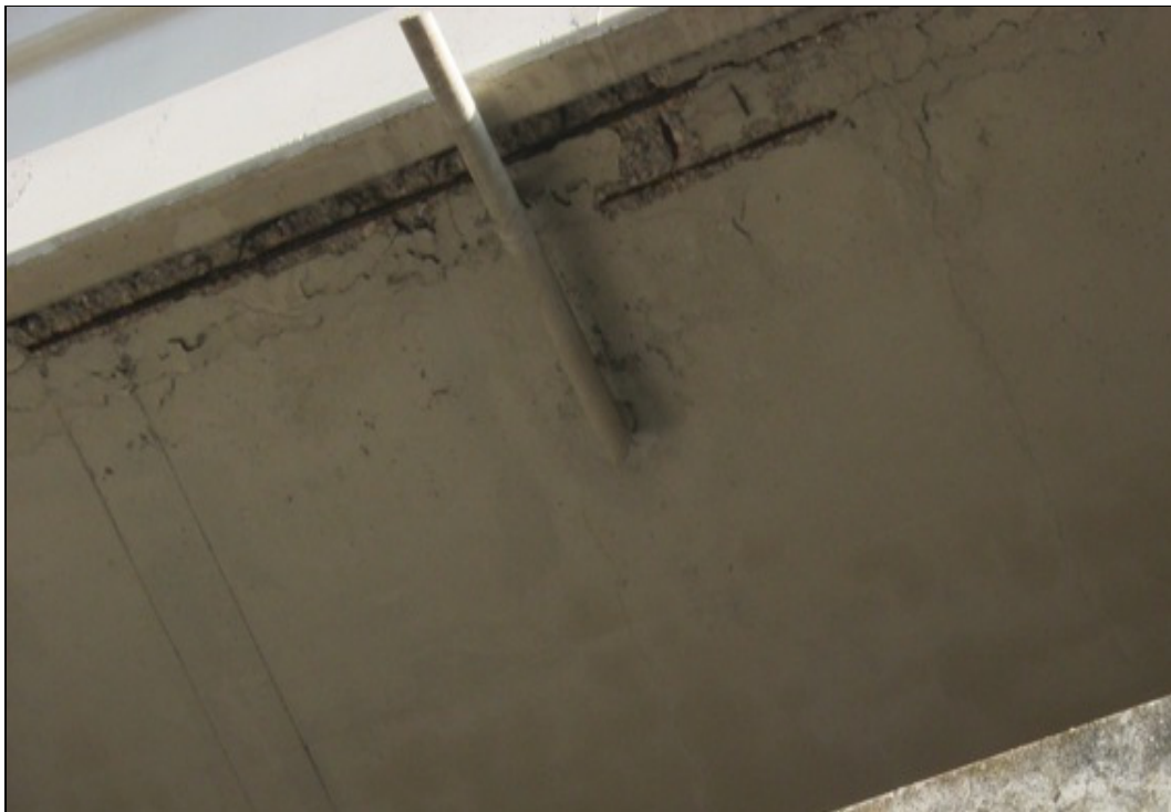
Foto 5 - Particolare fotografico dal quale si evince lo stato conservativo del copri ferro presente nei balconi.
