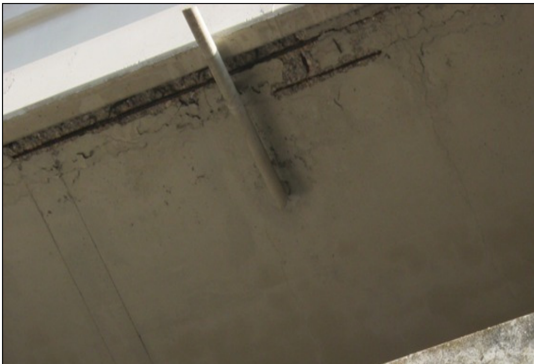
Foto 5 - Particolare fotografico dal quale si evince lo stato conservativo del copri ferro presente nei balconi.
